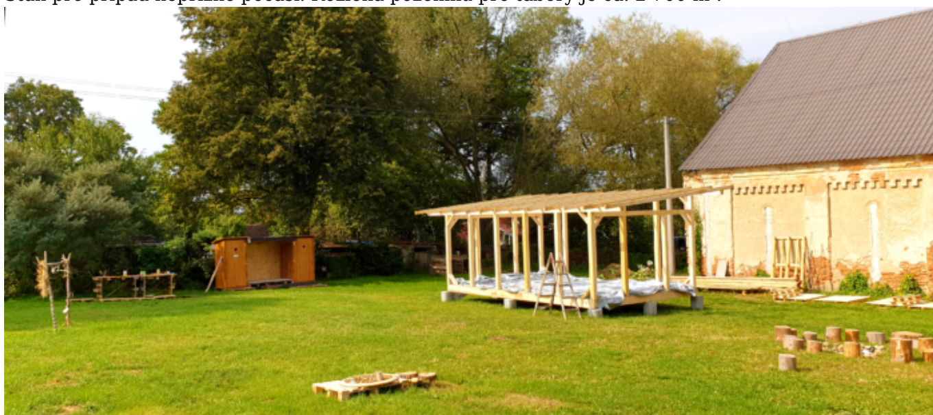
Stavba dřevěného přístřešku pro případ nepřízně počasí.
