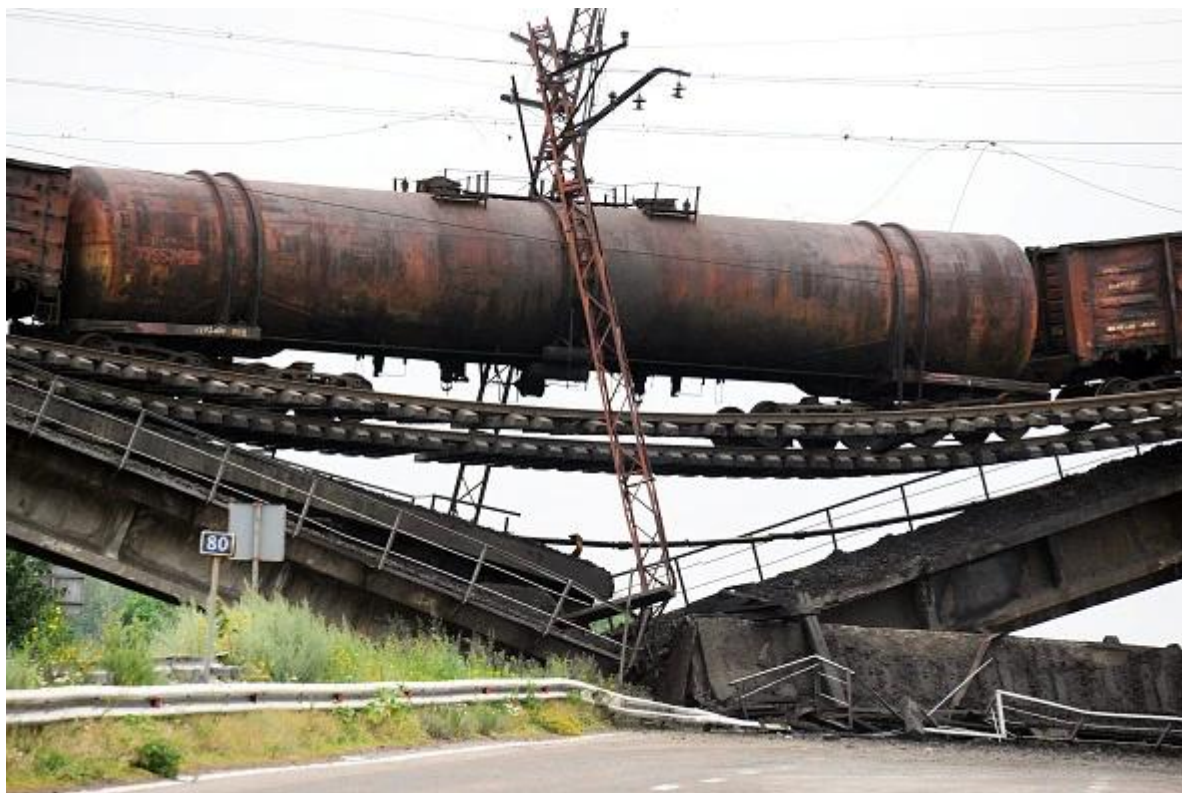
Zničený železniční most přes silnici mezi Slovianskem a Doněckem, 2014.
