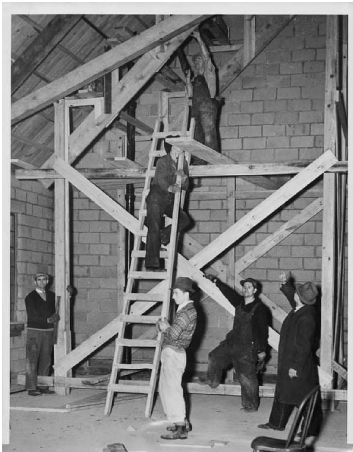
František Brdlík ovládal tesařské práce. Foto ze stavby v Brookfieldu v Illinois.
