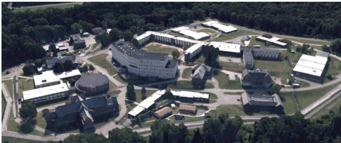
Nápravné zařízení Bedford Hills (foto Google Earth)
