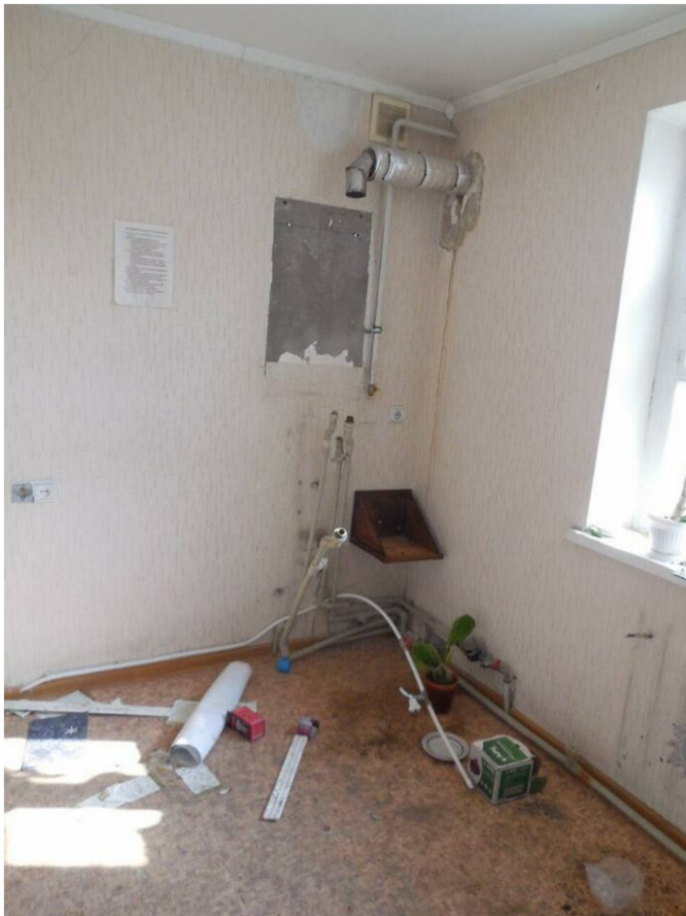
Demontovaný plynový kotel
