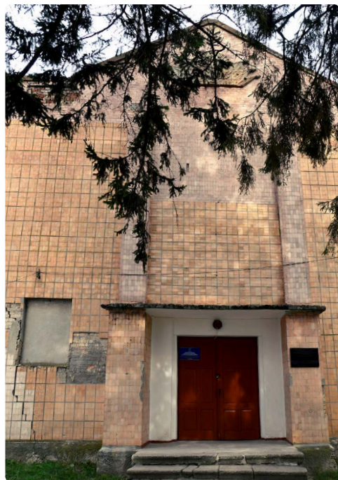
Průčelí baptistické modlitebny
