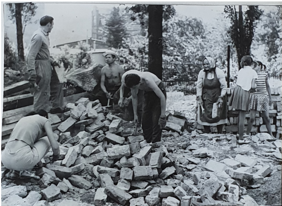
Obrázek 1 - Čistění cihel v ul. W. Piecha zdroj: Kronika stavby modlitebny
