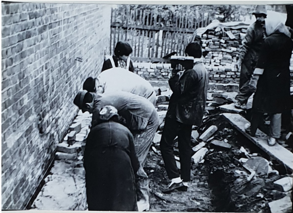
Obrázek 9 - První zeď, zdroj: Kronika stavby modlitebny
