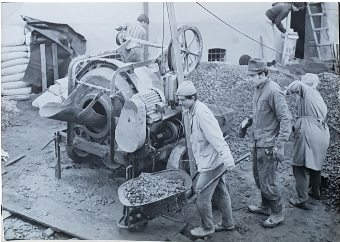
Obrázek 7 - Zpracovaný písek s cementem se sváží do příkopu, zdroj: Kronika stavby modlitebny
