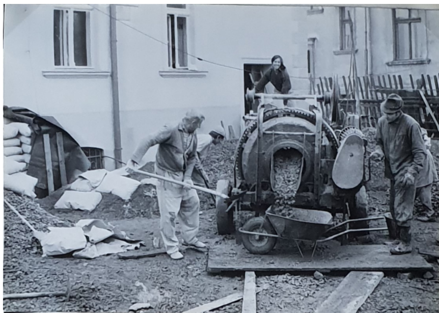
Obrázek 6 - Betonování, zdroj: Kronika stavby modlitebny
