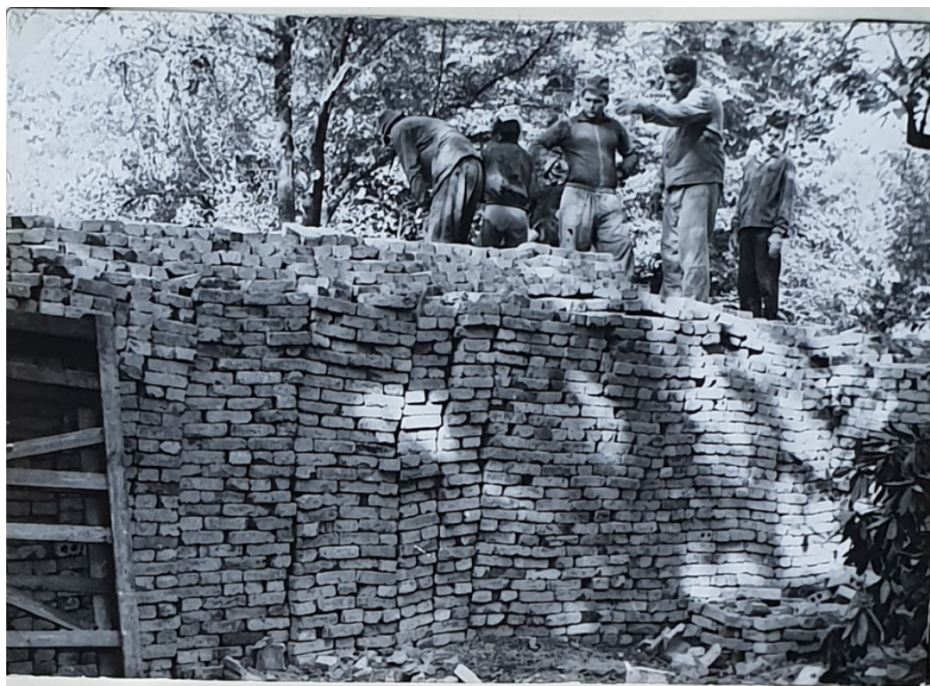
Obrázek 4 - srovnané cihly už jen stačí zakrýt, zdroj: Kronika stavby modlitebny
