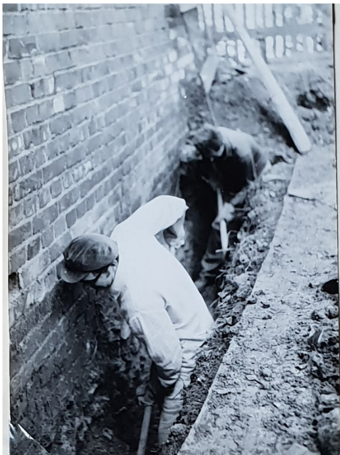
Obrázek 5 - poslední přípravy před betonováním, zdroj: Kronika stavby modlitebny
