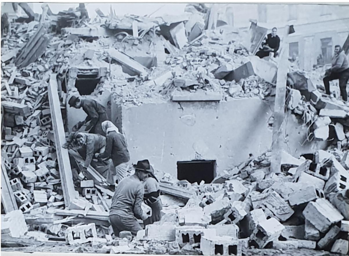
Obrázek 3 - Vybírání cihel, zdroj: Kronika stavby modlitebny
